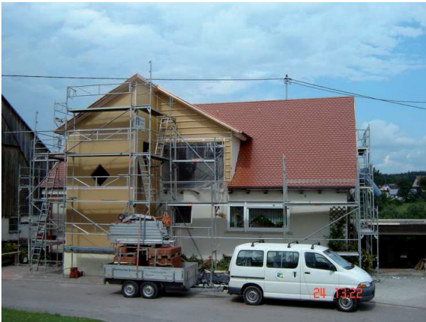
Dachsanierung mit Anbau in Holzrahmenbauweise und Balkon
