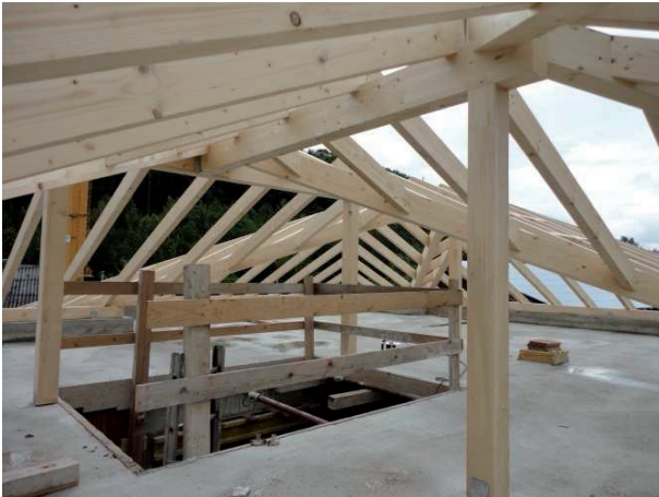
Dachstuhl in mediterranem Stil, nicht sichtbar
