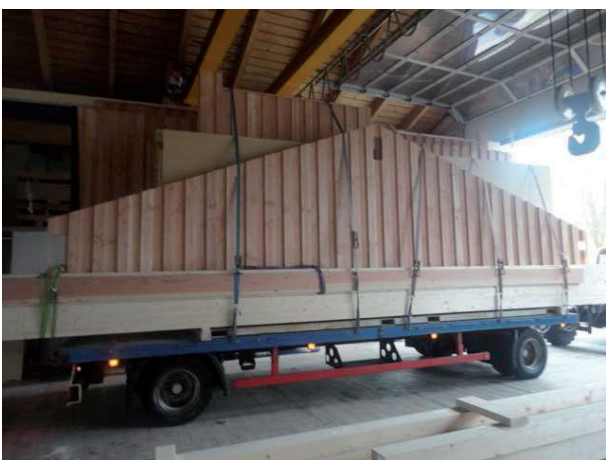
Holzfachwerk, vorgefertigte Wand- und Dachelemente mit Aussenschalung
