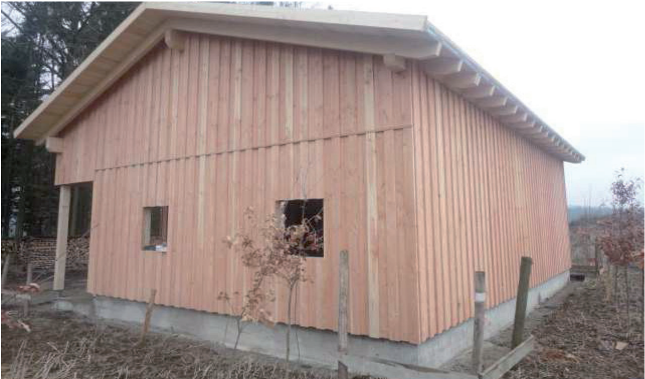
Landwirtschaftliches Betriebsgebäude mit witterungsbeständiger Lärche-Boden-Deckelschalung
