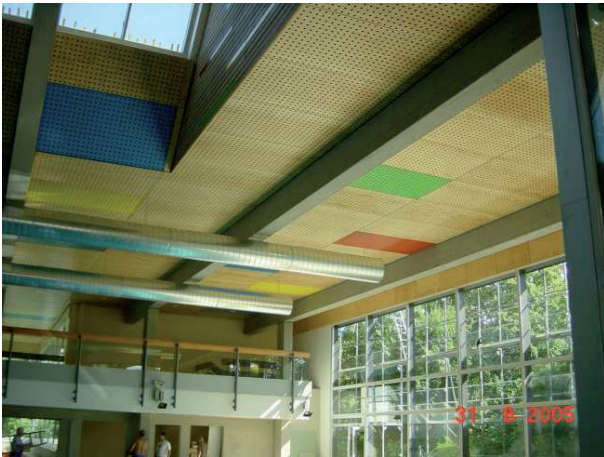
Deckenbekleidung aus perforierten Seekieferplatten
