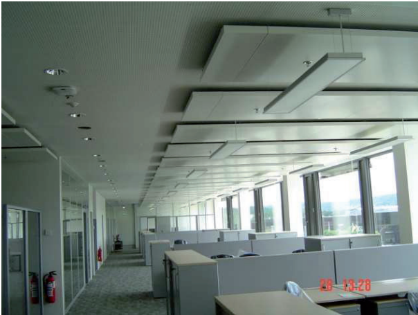
Büro, Kühldeckenflächen mit Krantz-Komponenten-Avacs-Kühlsegeln, 300 qm, mit integrierter Zu-/Abluft
